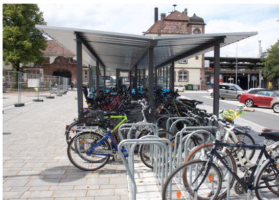
Überdachter Fahrradparkplatz am Bahnhof
